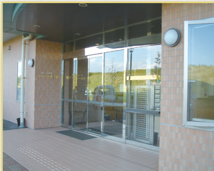
▲ケアハウス/エントランス
